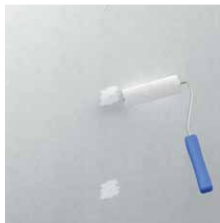
Krycí nanášení lepidla na spojovací prostředky ve středu desky
