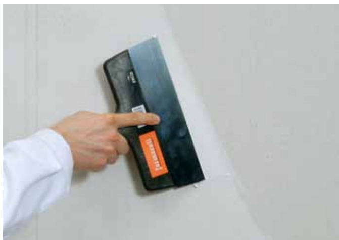
Plošné stěrkování sádrovláknitých desek fermacell
