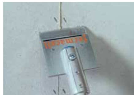
Odstranění přetoků lepidla pomocí škrabky fermacell
