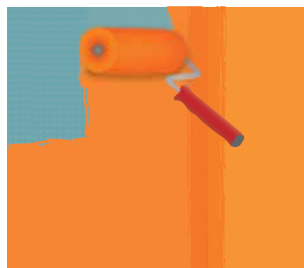
Tekutá fólie fermacell se nanáší celoplošně válečkem ve dvou vrstvách (celková tloušťka \geq 0,5 mm)
