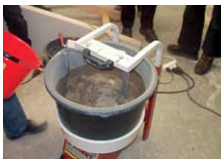
Míchání výplňové malty fermacell
