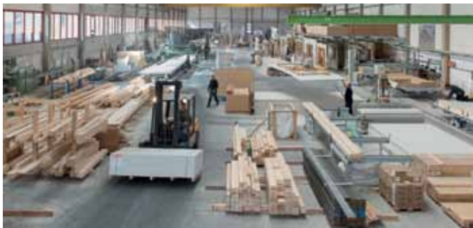
Výroba dílců dřevostavby se sádrovláknitými deskami fermacell
