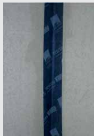
Vzduchotěsné prolepení vnitřního rohu desek fermacell Vapor
