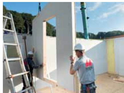
Montáž na staveništi
