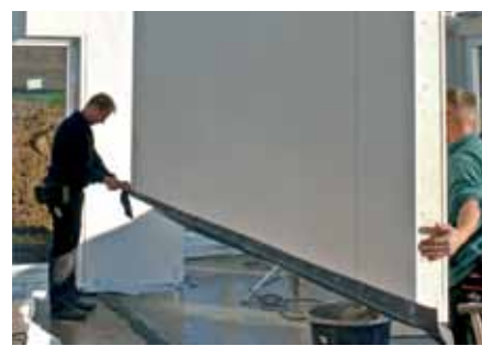
Osazení stěnového panelu do maltového lože
