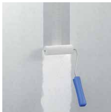
Nanášení armovacího lepidla fermacell HD válečkem
