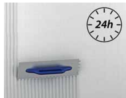
Nanesení druhé vrstvy lehké malty fermacell v tl. 2 – 3 mm po vytvrzení armovací vrstvy (varianta A)
