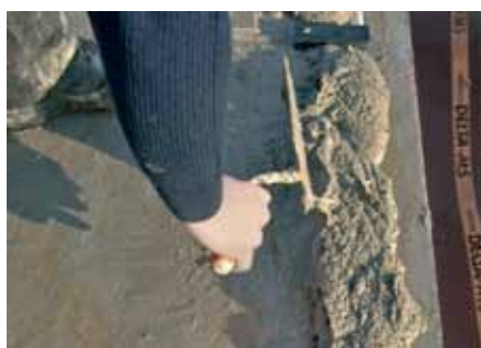
Nanášení maltového lože
