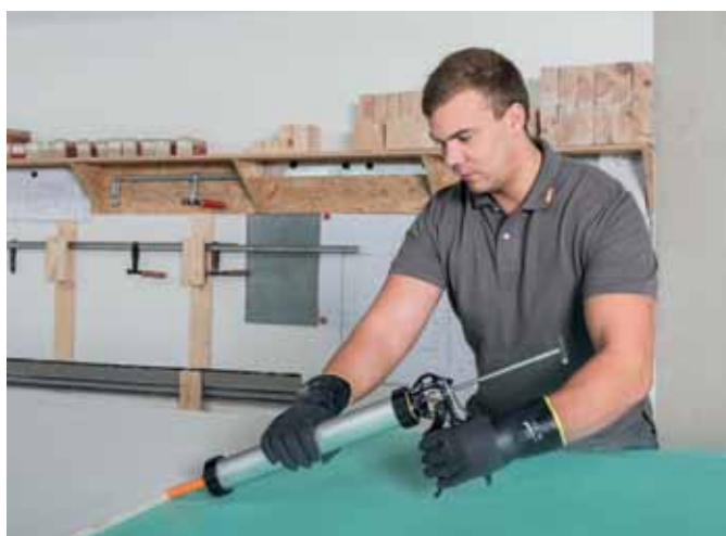
Nanášení spárovacího lepidla fermacell z praktického 580 ml balení ve folii
