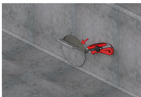
4. Proříznout (odkrýt) asfaltovou hi v místě prostupu atikou
