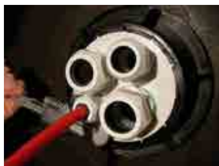
5. Potrubí/kabel protáhnout prostupovým šroubením a svěrnou maticí zajistit pozici potrubí v prostupu.
