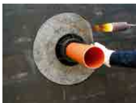
5. Natavit asfaltovou manžetu na podklad
