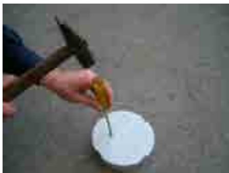
2. Podle počtu průstupů potrubí/kabelů a jejich průměrů zvolit prostupová šroubení a vylomit odpovídající prostupové otvory
