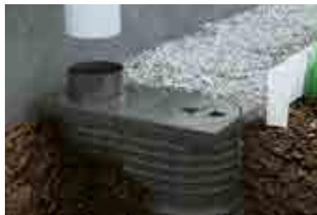
3. Napojte dešťové odpadní potrubí
