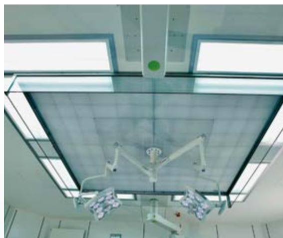
Přívodní strop CG
