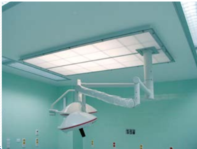
Přívodní strop CG - OP sál gynekologie
