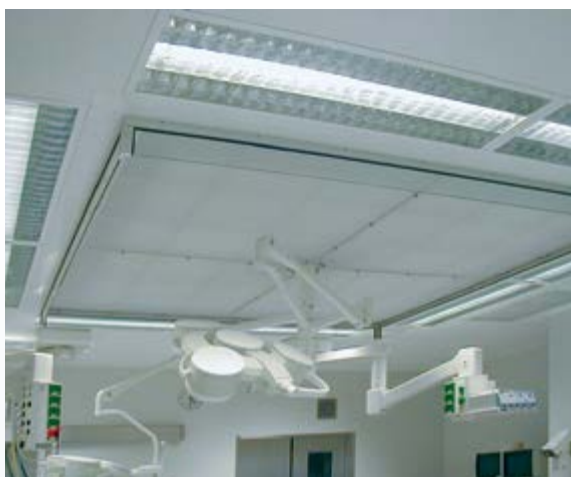
Přívodní strop CG
