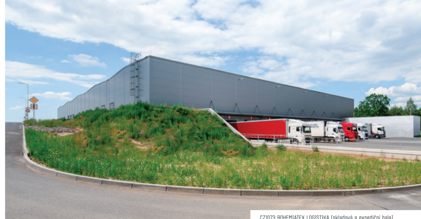
CZ1073 BOHEMIATEX LOGISTIKA (skladová a expediční hala)
