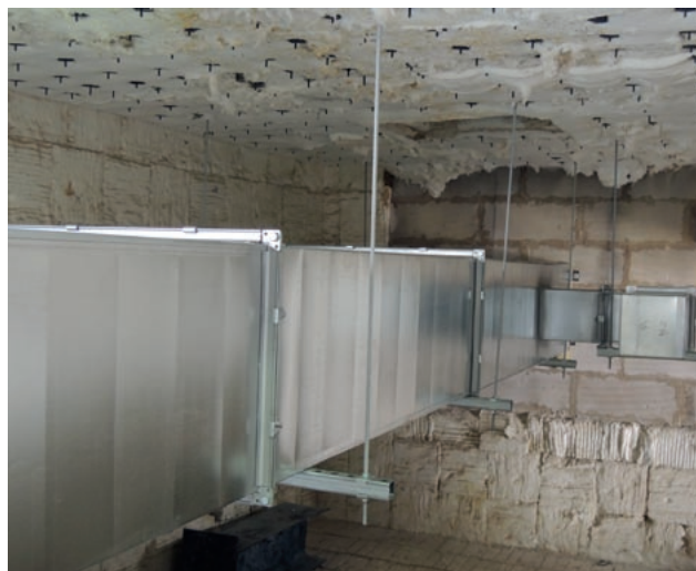
Obr. 21 Standardní jednovrstvé kladení izolace v místě přírub
