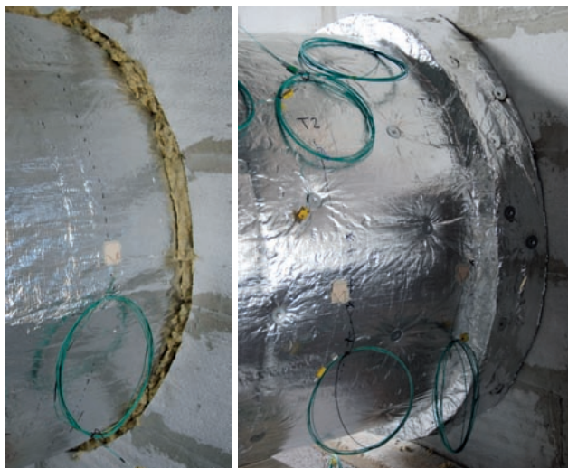
Obr. 31 Před provedením izolační manžety z druhé vrstvy lamelové rohože se nejdříve docpe meziprostor mezi izolovaným potrubím a požárně dělicí konstrukcí
