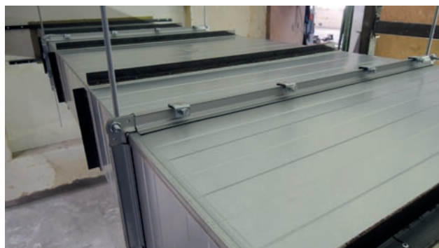
Obr. 59 Vnější vyztužení L-profilů
