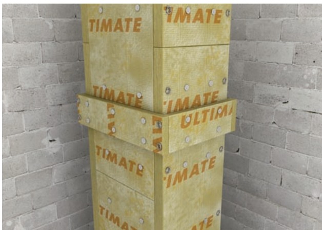
Obr. 42 Rozmístění trnů a vrutů Fire Screw u přidavné druhé vrstvy izolace
