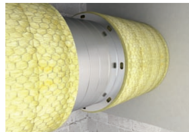
Obr. 52 V případě požadavku požární odolnosti EI 120 ovšem potrubí vyžaduje vnější zesílení pomocí kruhových obručí 40 × 5 mm umístěných mezi závěsy po vzdálenostech 1200 mm (šířka rohože je 600 mm)
