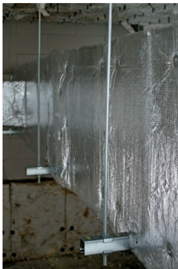
Obr. 23 Zavěšení potrubí závitovými tyčemi a instalačními profily. Na obrázku závitové tyče umístěny vně izolace (část instalačního profilu vyčnívajícího z izolace se v tomto případě neizoluje).
