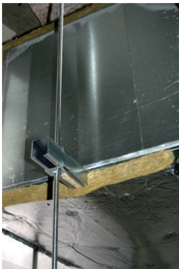
Obr. 22 Izolování instalačního profilu výšky 40 mm izolační tloušťky 40 mm
