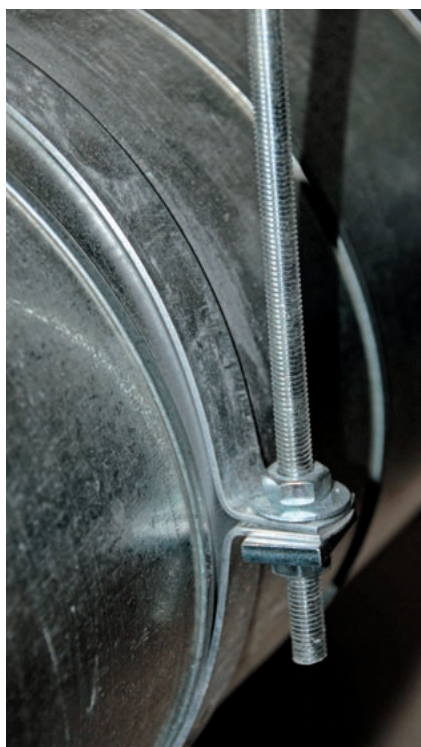
Obr. 27 Detail dvoudílné objímky pro zavěšení kruhového potrubí
