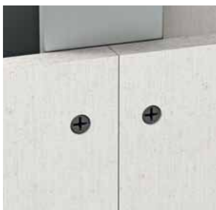
Těsné napojení desek – šířka spáry: \leq 1 mm
