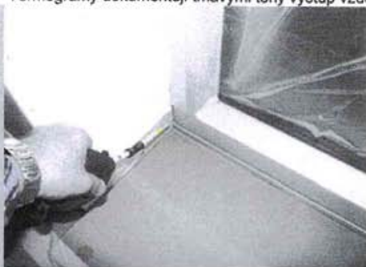
Netěsný roh okna hlavního jižního zasklení 1NP ▶ JV i JZ okno - opakovaná závada
