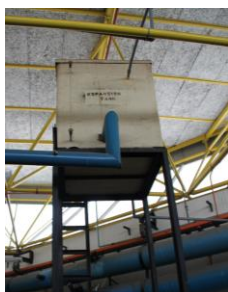
Otevřený oběhový systém (otevřená nádrž v nejvyšším bodě)
