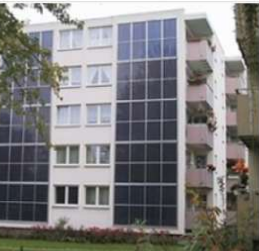
Obrázek 5: Aplikace fotovoltaických panelů na štítovou fasádu.
