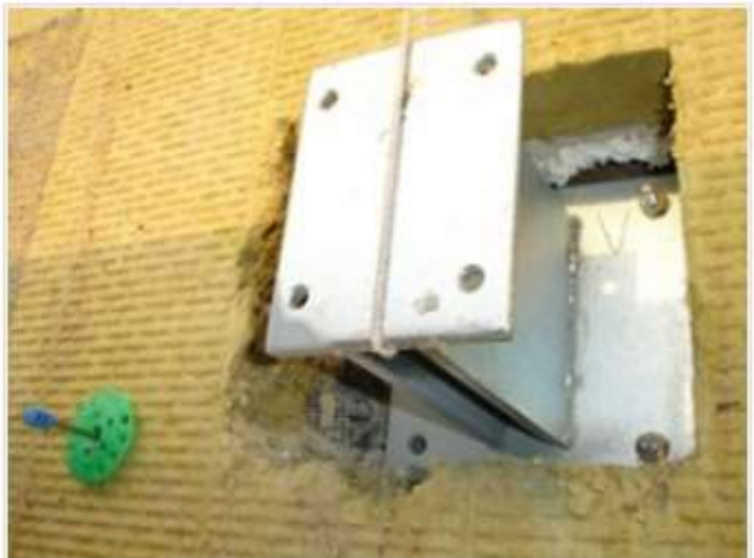
Obrázek 6: Kotva fotovoltaického systému v zateplené stěně. (ČVUT)
