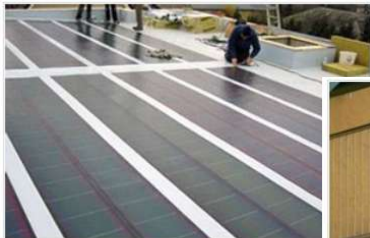
Obrázek 3: Instalace tenkovrstvé fotovoltaiky
