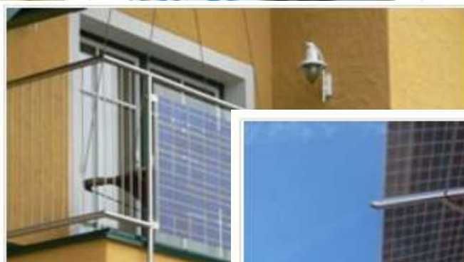
Obrázek 3: Instalace tenkovrstvé fotovoltaiky
