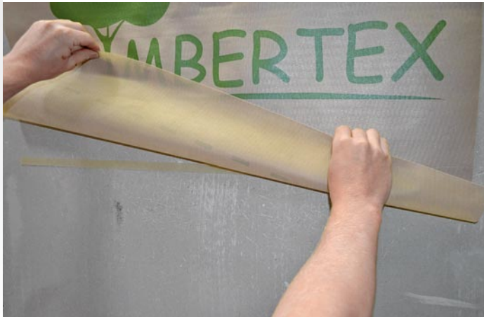
POTOM SE PŘEKLOPÍ PAROBRZDA, KTERÁ SE MÁ LEPIT...
