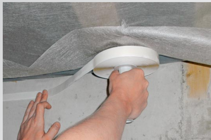
TĚSNICÍ HMOTA AIRSTOP DIMAROLL SPOLEČNOSTI ISOCELL SE ZPRACOVÁVÁ JAKO LEPICÍ PÁSKA
