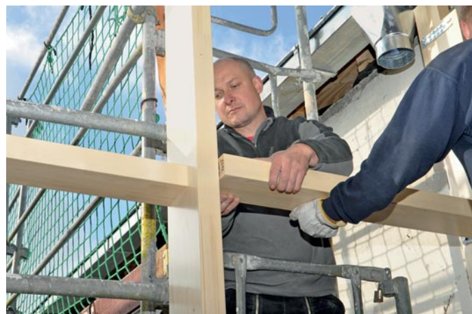
Plynulou montáž konstrukce zvládnou dva dělníci
