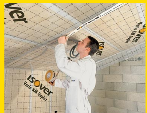
Ukázka z montáže folie Vario KM Duplex UV
