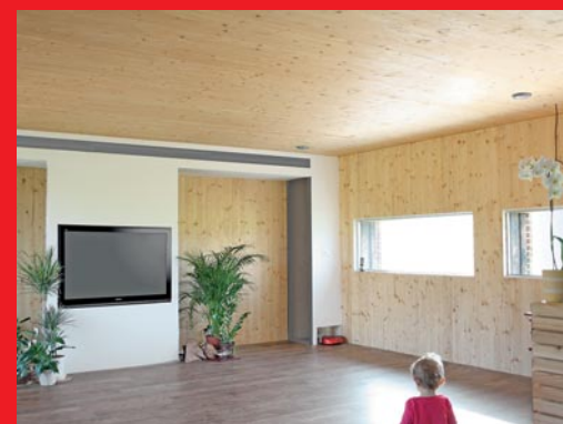
KOMPONENTY DODANÉ PŘÍMO NA STAVENIŠTĚ JSOU VYROBENY VČETNĚ VEŠKERÝCH FUNKČNÍCH VÝŘEZŮ
