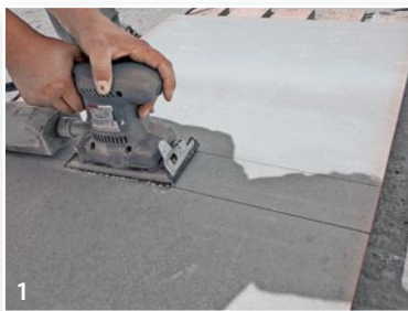
Lepení – zbroušení povrchu
