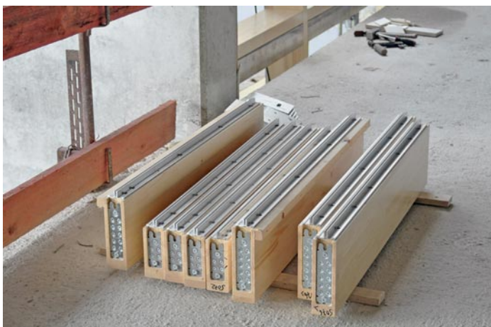
Předvýroba nezávislá na počasí: vodorovné konstrukční prvky z vrstveného dřeva s hliníkovými profily a systémem Ricon
