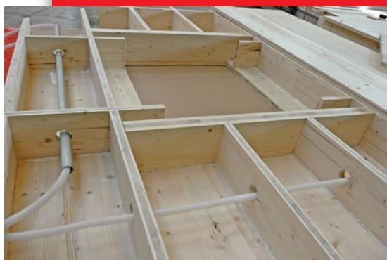
PŘÍPRAVA TRAS PRO ROZVODY V ELEMENTU
