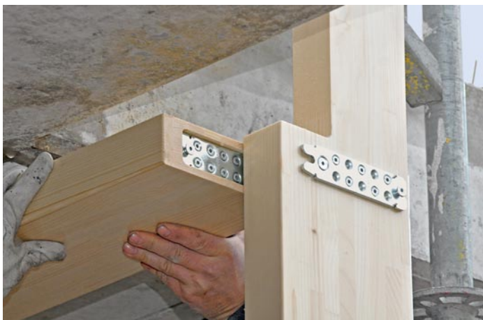
Vodorovné fošny se zapuštěným protikusem se snadno nasunou na připevněnou nosnou destičku
