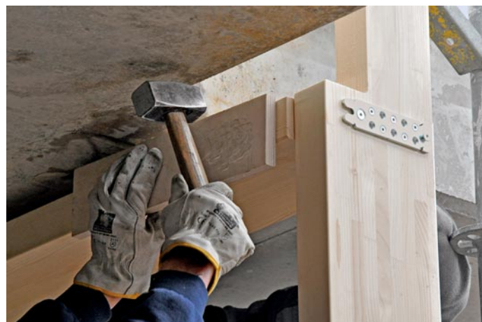
Několik úderů kladivem zajistí dokonalé zapadnutí obou částí systému Ricon do sebe
