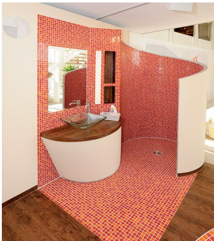
Ohýbané konstrukce z desek FERMACELL Powerpanel H2O
