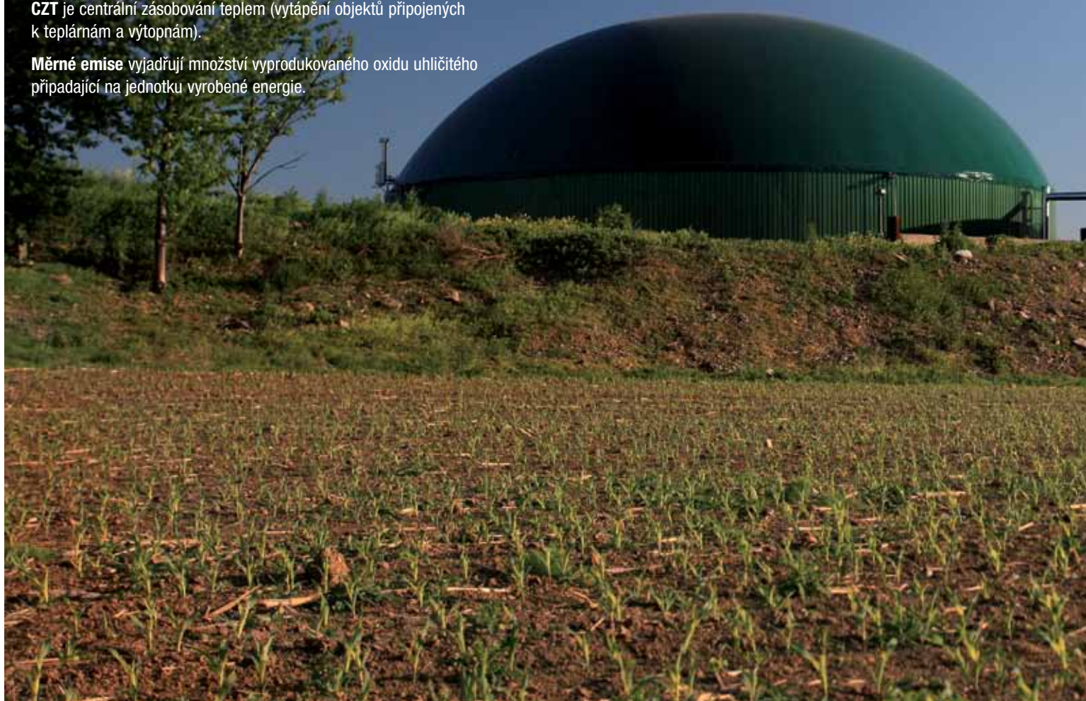
foto BIOPLYNOVÁ STANICE V OBCI HODKOVICE VE STŘEDOČESKÉM KRAJI. JEDNÁ SE O PRVNÍ BIOPLYNOVOU STANICI, KTERÁ DOKÁŽE ZPRACOVÁVAT VELKÉ MNOŽSTVÍ SLAMNATÉ MRVY BEZ NUTNOSTI JEJÍ PŘEDÚPRAVY, DRCENÍ CI ŘEZÁNÍ.
