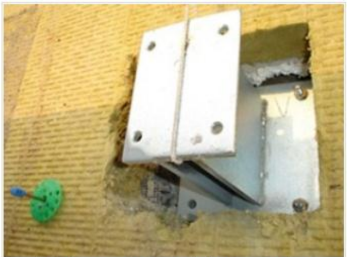
Obrázek 6: Kotva fotovoltaického systému v zateplené stěně. (ČVUT)
