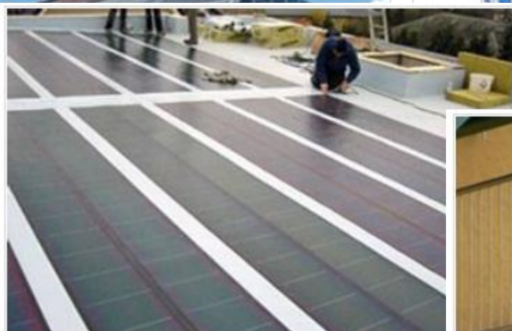
Obrázek 3: Instalace tenkovrstvé fotovoltaiky
