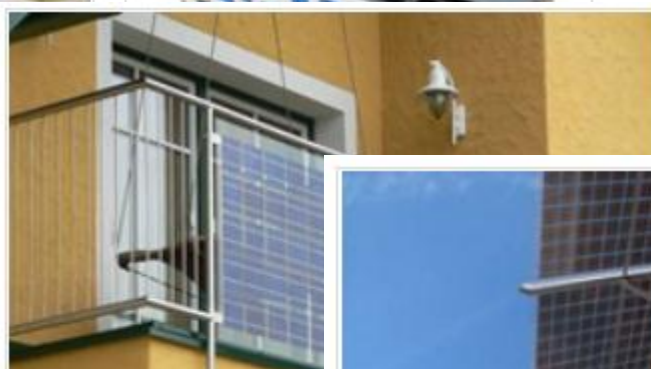
Obrázek 3: Instalace tenkovrstvé fotovoltaiky
