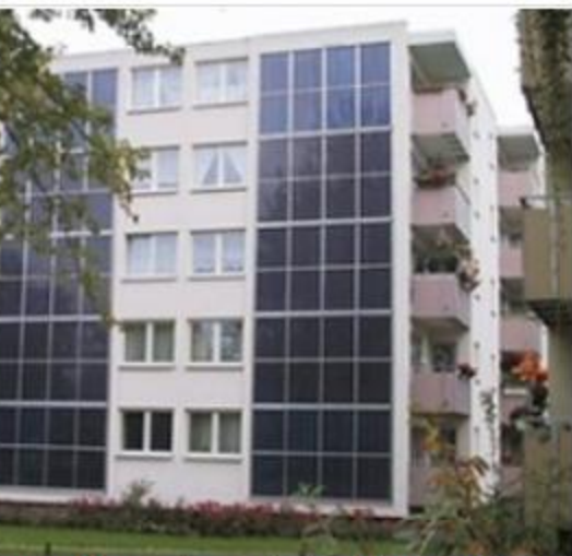
Obrázek 5: Aplikace fotovoltaických panelů na štítovou fasádu.
