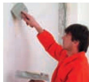
Vyplnění spár mezi deskami tmelem (obr. 21)
