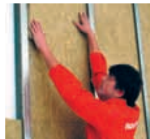
Vyplnění příčky akuzolací (obr. 17)
