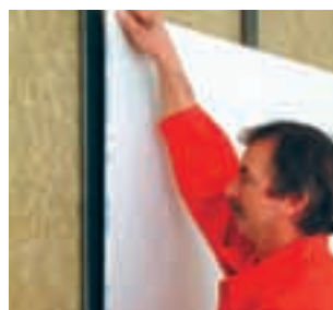
Montáž sádkartonových desek (obr. 20)
