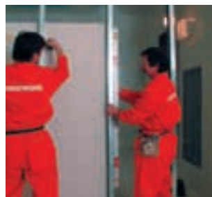
Montáž kovových nosných profilů (obr. 16)
