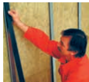
Lepení separační samolepicí PE pásky na kovové profily (obr. 19)
