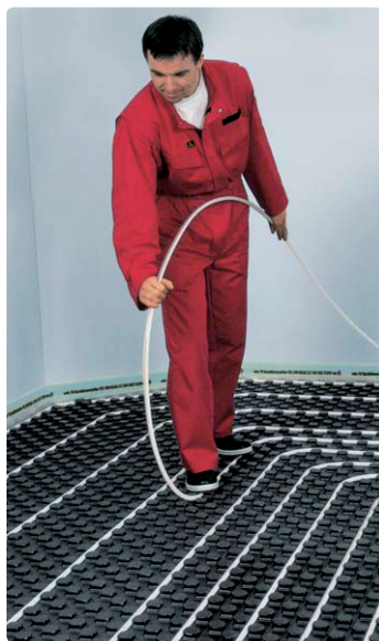
Jednoduchá montáž tecto prvků i velta PE-Xa trubky - stačí jeden pracovník. Prvky se zatlačí nohou a je hotovo.
