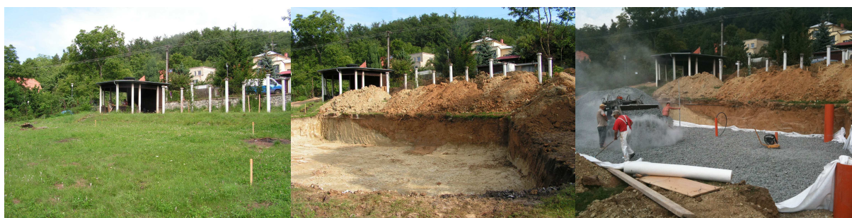
Obr. 3 Izolace pěnovým sklem
