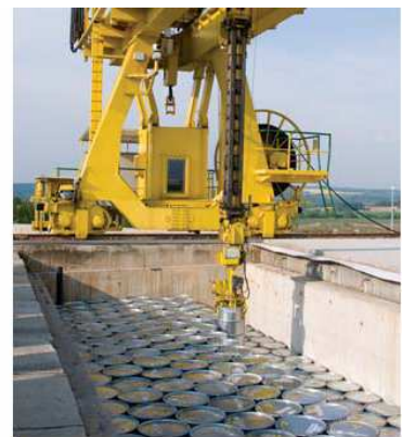
b) Umísťování sudů s odpadem do jímky
