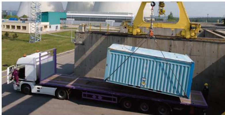
d) Skládání transportního kontejneru s 35 sudy RAO na úložišti Dukovany
