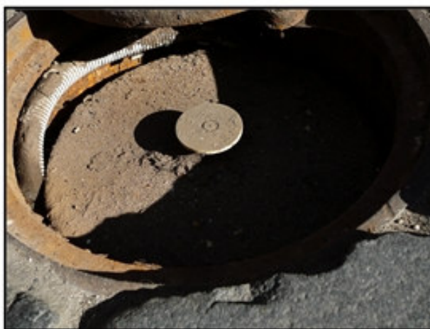
Obr. 17 - Zatopení regulační soupravy způsobilo zvýšení přetlaku v domovním rozvodu plynu, plameny plynového sporáku dosahovaly výše 45 cm a způsobily požár kuchyně.
