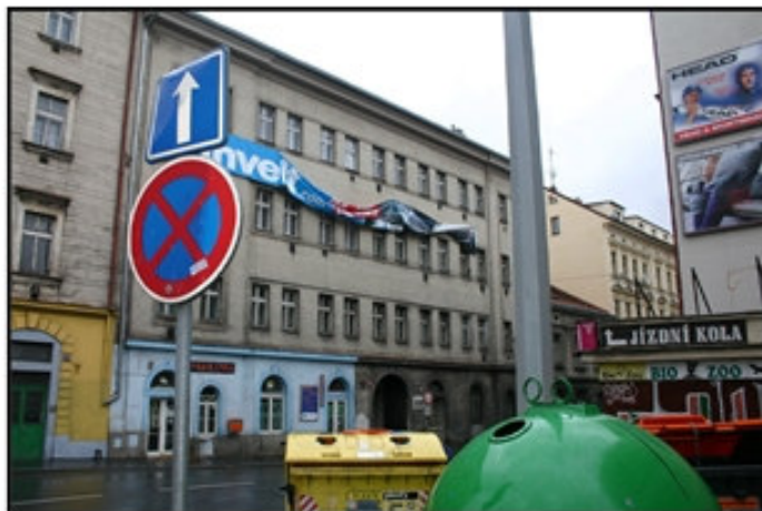
Obr. 16 - Instalace reklamního panelu zakrývajícího vyústění plynových lokálních topidel v provedení C.
