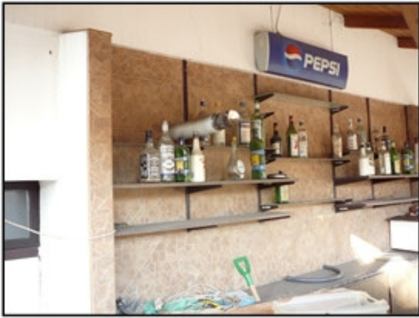
Obr. 8 - Vyústění odvodu spalin a přívodu vzduchu do prostoru baru.
